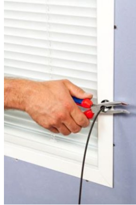
Bild 22: Abschneiden der Welle
