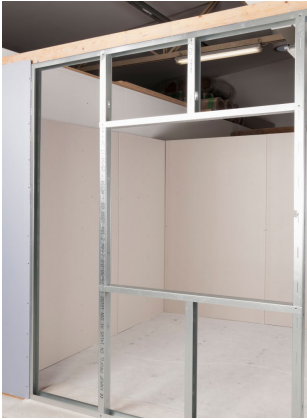
Bild 2: Öffnung in Metallständerwand herstellen
