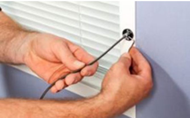
Bild 21: Festschrauben der Welle
