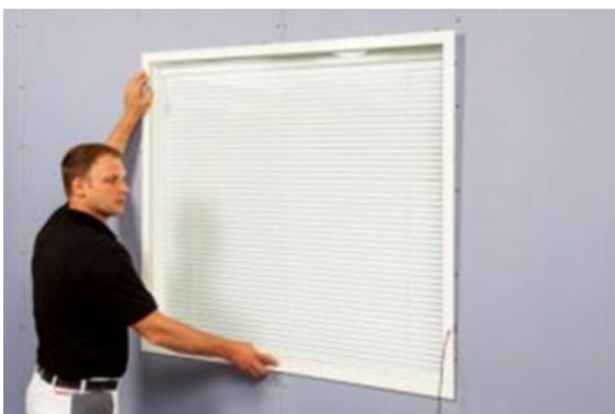
Bild 17: Einsetzen des Abdeckrahmens
