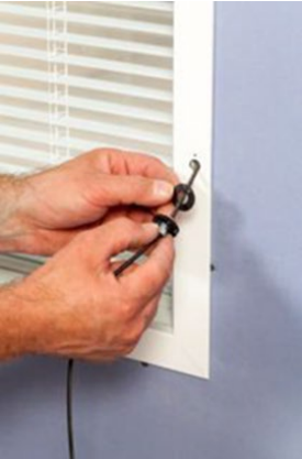
Bild 19: Einfädeln des Drehknopfs
