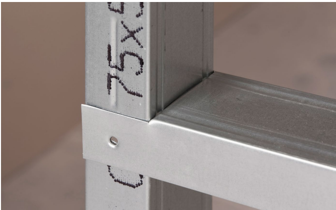
Bild 3: Anlaschen des Sturz-/Brüstungsprofils
