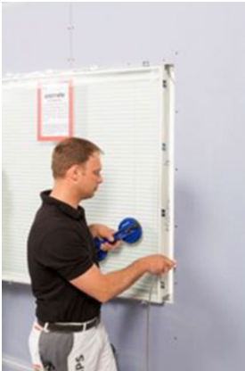
Bild 13: Einsetzen des Monoblockglaselements
