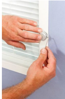
Bild 23: Aufsetzen und Festschrauben des Drehknopfs
