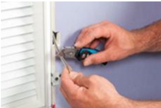
Bild 16: Einschneiden der Welle
