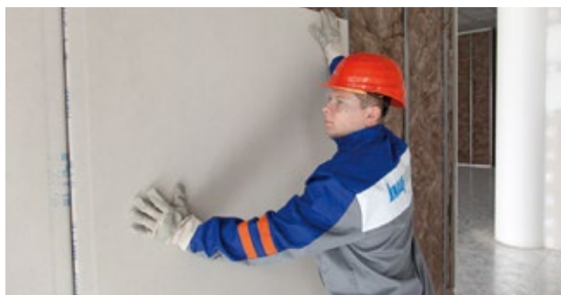
4. Instalace první vrstvy sádrokartonových desek na připravený rošt.
