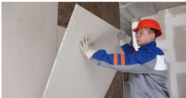
5. V případě kdy je prováděna montáž druhé vrstvy opláštění, musí druhá vrstva překrývat spáry mezi deskami v první vrstvě.
