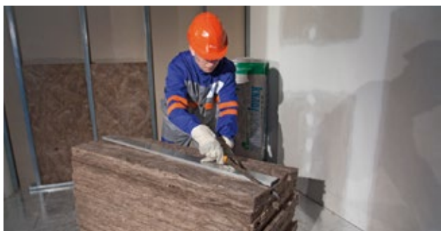
3. Desky z minerální vlny Knauf Insulation se snadno formátují s pomocí vhodného nože.
