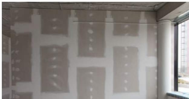
6. Finální provedení se ztmelenými styky desek a zapuštěnými hlavičkami vrutů.
