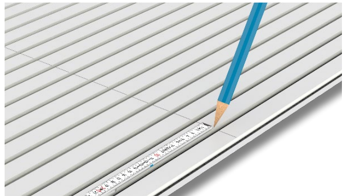
Bild 7: Cleaneo Stripe Board 20 ausrichten
