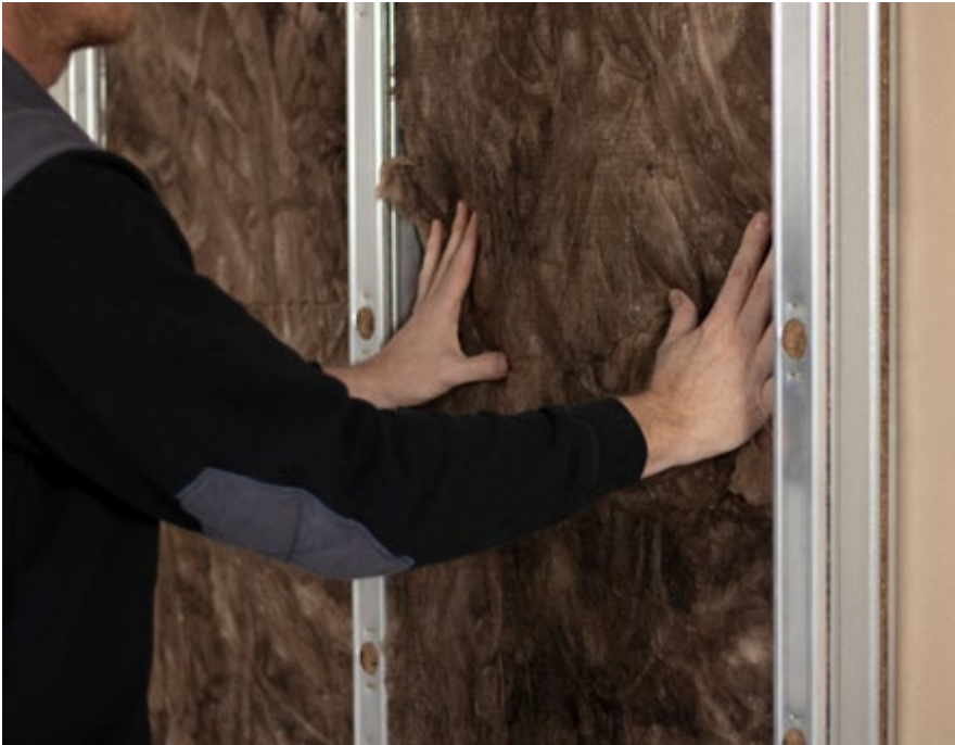
Aanbrengen van Knauf Acoustifit tussen de staanders.
