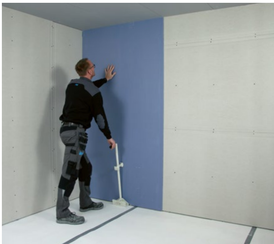
Aanbrengen van Knauf Diamond Boards als tweede beplating.
