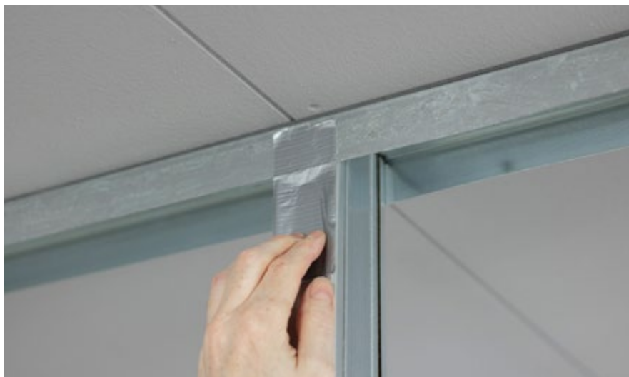
Tijdelijk fixeren van de Knauf MaxSpace staanders aan het UW-profiel met ducttape.
