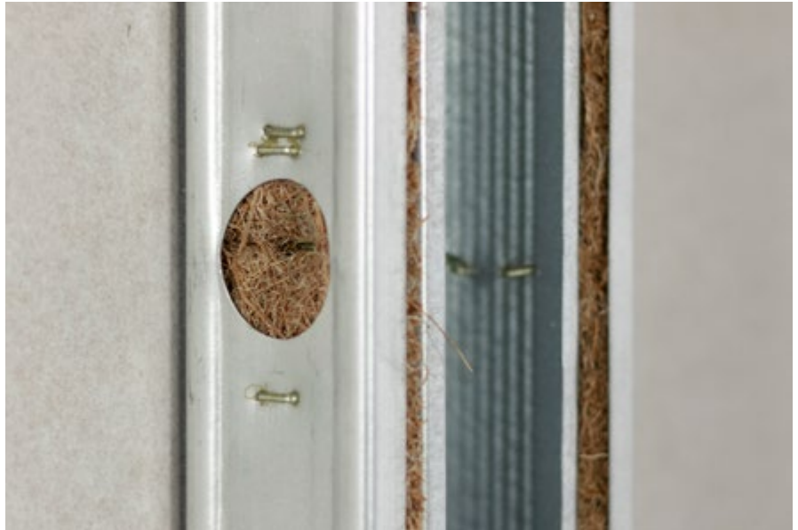
De wand wordt aan beide zijden bekleed met 12,5 mm Knauf A-plaat en 12,5 mm Knauf Diamond Board. De spouwruijnte wordt voorzien van 60 mm glaswol Knauf Acoustifit. De totale wanddikte bedraagt 125 mm.
