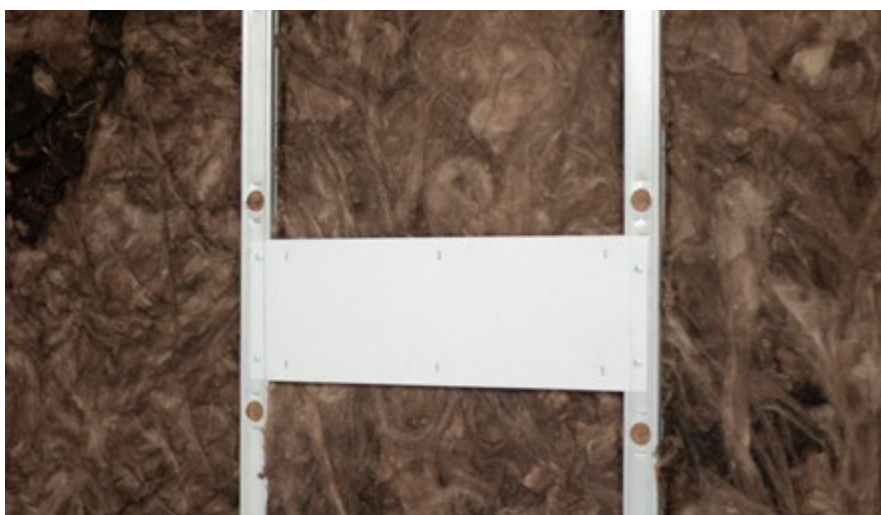
Bevestig eventueel benodigde Knauf MaxSpace-traverses op de juiste plekken tussen de staanders met vier stuks snelbouwparkers (lengte max. 10 mm).
