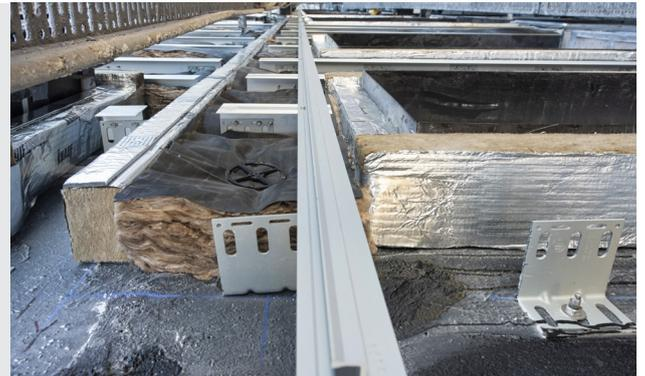
**3** El ancho total de la barrera es 5mm más ancho que el ancho total de la cámara de fachada. De manera que cuando se coloque el acabado de fachada (piel) ésta haga presión sobre la barrera vertical y de esta manera quede sujeta.
