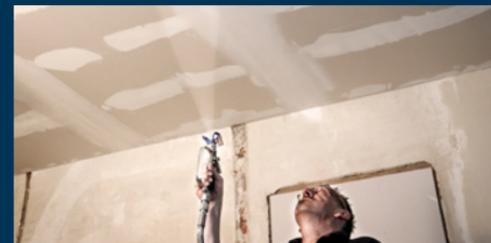
Für die Verarbeitung mit Airless-Geräten von Spritzspachtel Plus eignen sich Airless-Geräte, deren Leistung auf die Verarbeitung von pastösen Spachtelmassen ausgelegt ist (z. B. Knauf PFT Swing Airless, Graco Mark V, VII, X, Wagner HC).
