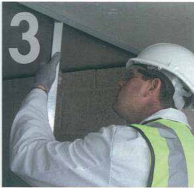
3 Twisting Knauf 'C' Stud into position.
