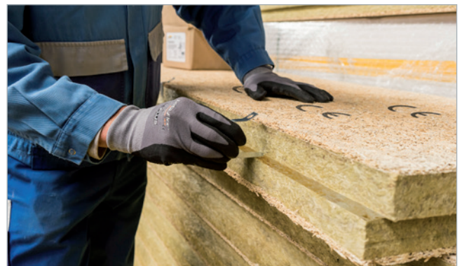
Eindrücken der Heraklith Falzanker.
