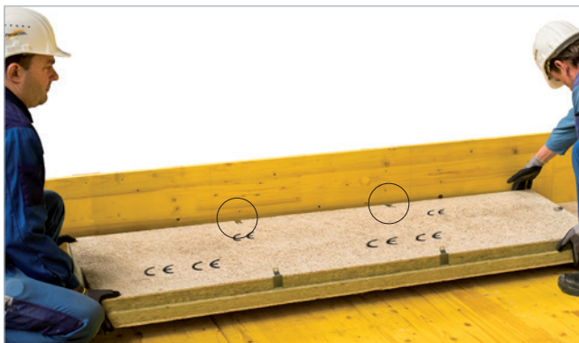
Zusätzlich 2 Stück Heraklith Falzanker im Randbereich.
