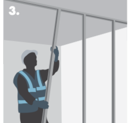
3. Twisting Knauf 'C' Stud into position.
