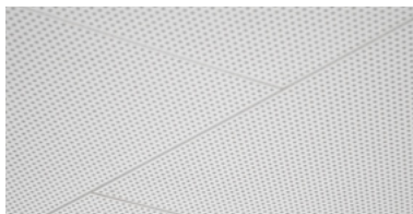
Pose à joint de pierre
