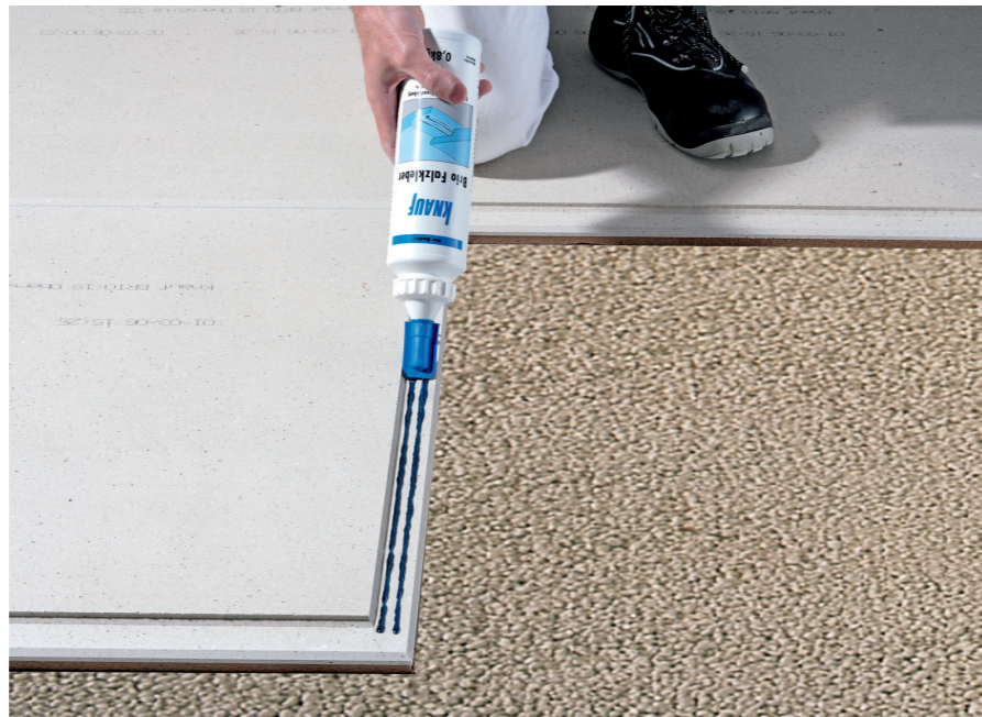
Verlijmen van de verbindingslip met twee rupsen Brio voeglijm voor Brio.
