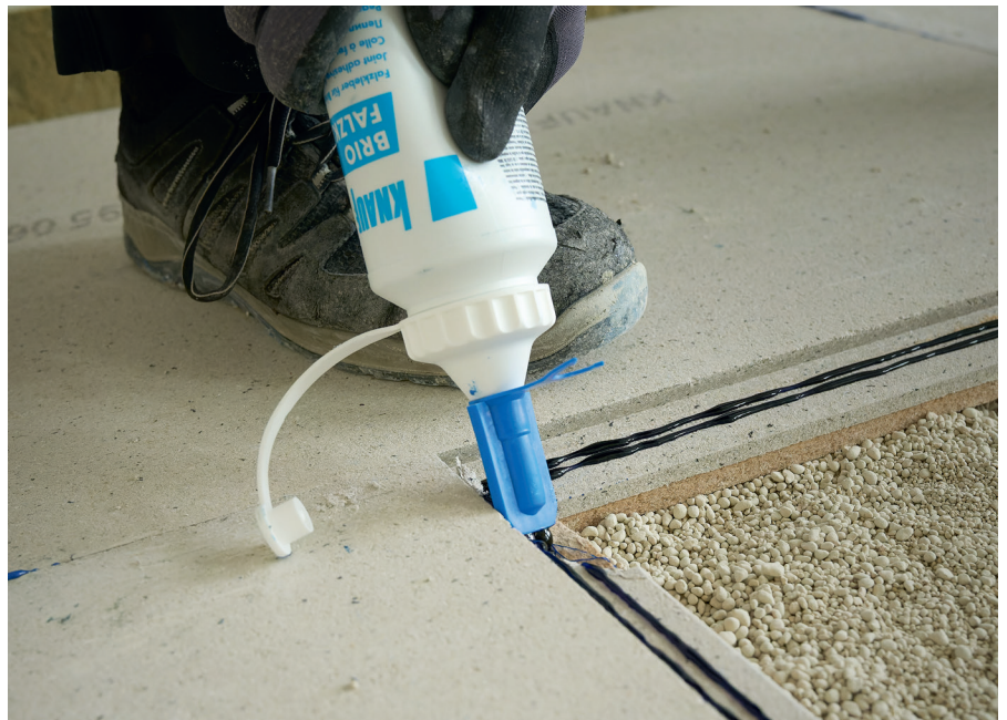
Verlijmen van de verbindingslip met twee rupsen Brio voeglijm voor Brio.
