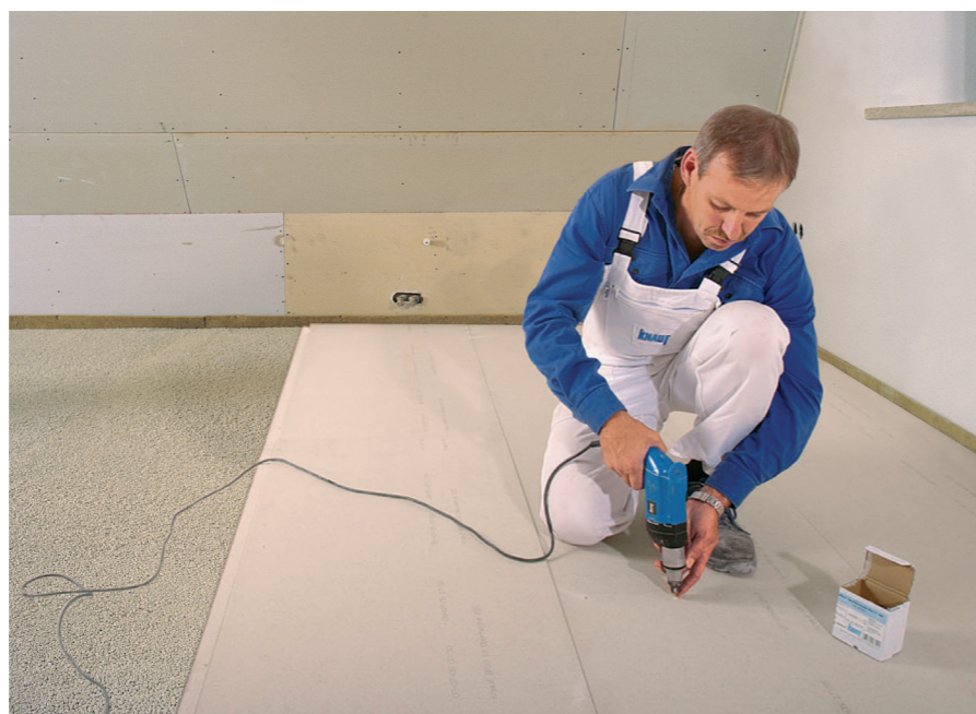
Het bovenliggende Brio element tijdens het lijmen en schroeven aandrukken met het eigen lichaamsgewicht.
