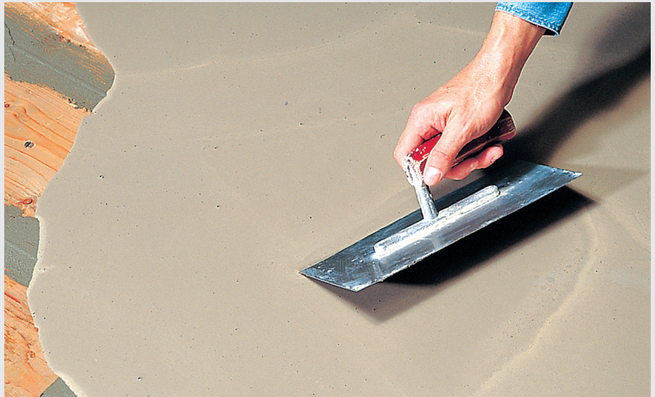
Egalisatie van houten vloer met Knauf Egalisatie Universeel.
