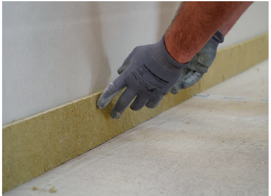
De montage begint met het aanbrengen van randisolatiestroken.
