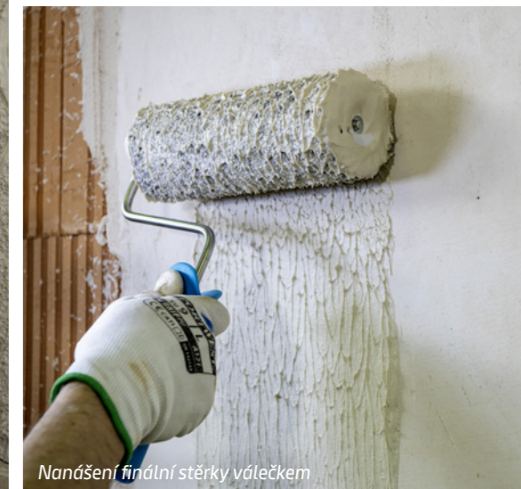
Když investor požaduje kvalitu Q3 nebo Q4, je třeba aplikovat finální stěrku Roll & Spray
