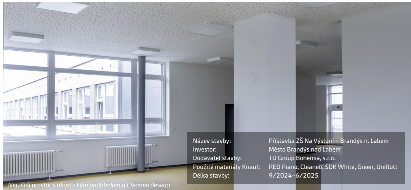
V každé třídě je požární podhled, ze kterého je svěšený akustický podhled s deskou Cleaneo
