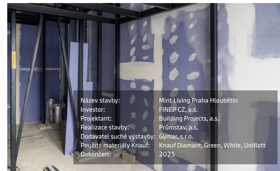
Mezibytové příčky a klasické příčky jsou provedeny celé v modrém – konstrukce s deskami Knauf Diamant
