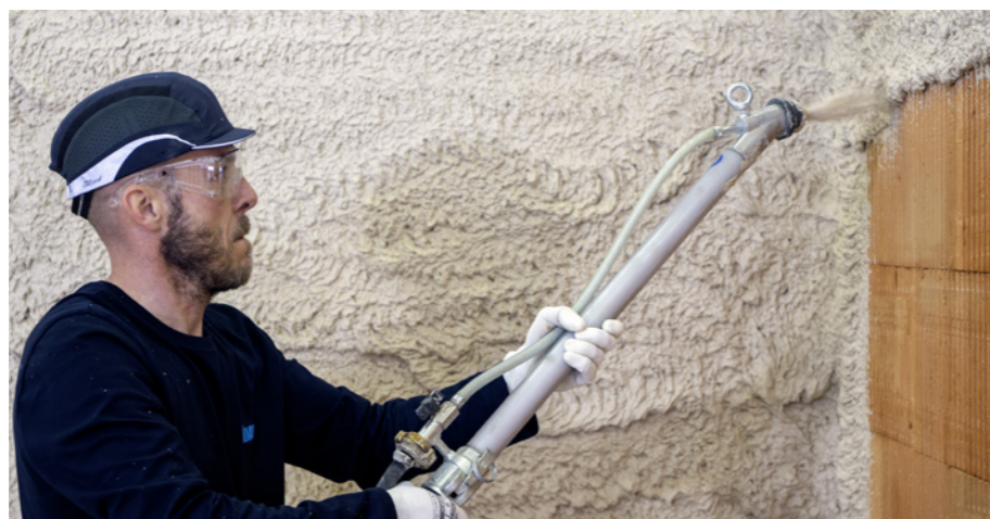
Aplikace sádrové omítky tradiční omítačkou
