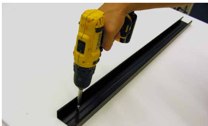
Obr. 11: Upevnění profilu CD na Cleaneo Single Smart pomocí šroubů
