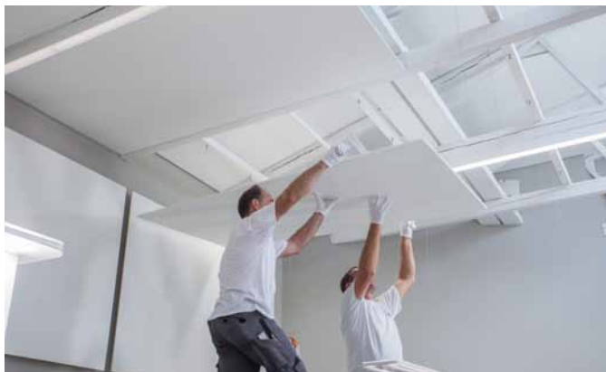
Obr. 23: Vyrovnání stropního dílce Cleaneo Single Smart
