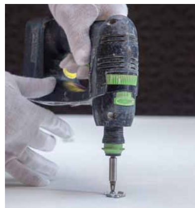
Obr. 6: Upevnění plechových držáků
