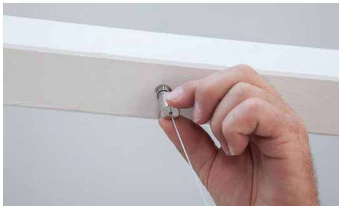
Obr. 21: Pevně přišroubujte vrchní díly závěsu
