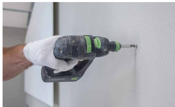
Obr. 7: Pevné přišroubování magnetických patic.
