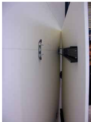
Obr. 14: Osazení stěnového absorberu Cleaneo Single Smart
