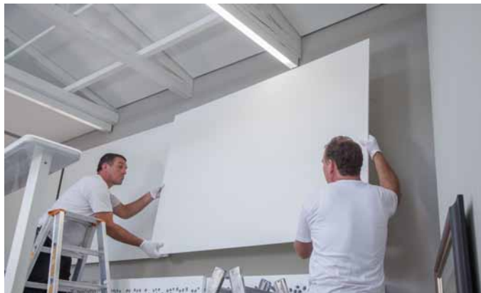
Obr. 9: Umístění stěnového absorberu Cleaneo Single Smart
