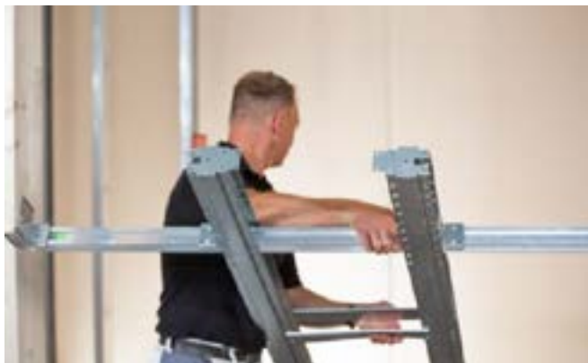
Фигура 21: Регулиране на Pocket Kit Easy Система за плъзгащи врати
