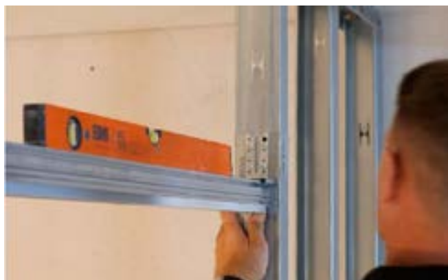
Фигура 33: Подравняване на релса
