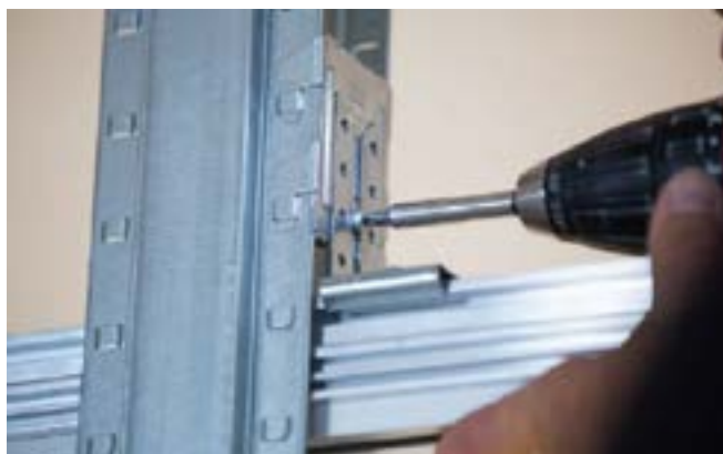
Фигура 34: Фиксиране на окачването на монтажната релса
