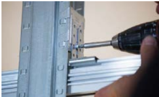
Фигура 32: Регулиране на окачването на монтажната релса
