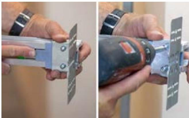
Фигура 19: Фиксиране с винтове и затягане на окачването към монтажната релса.
