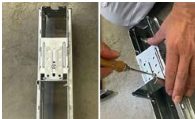
Фигура 11: Настройка на дистанционера
