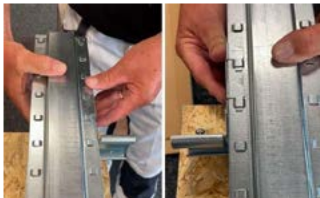
Фигура 10: Монтаж на дистанционера
