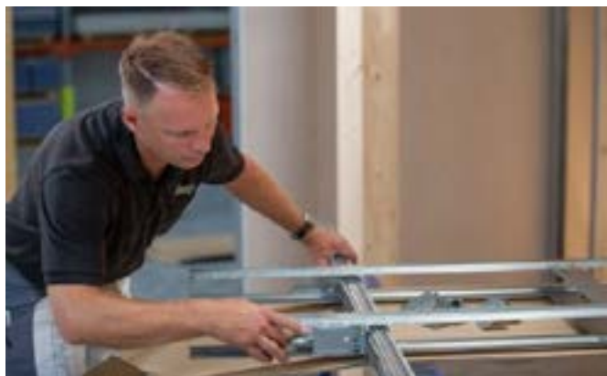
Фигура 16: Монтаж на монтажната релса
