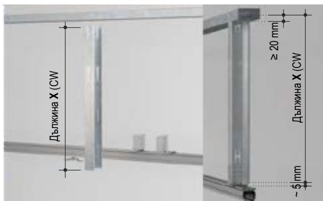
Фигура 27: Отрежете допълнителен CW профил на необходимата дължина
