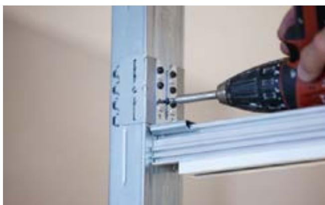
Фигура 35: Фиксиране с винтове
