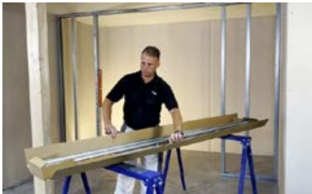
Фигура 6: Частично сглобена Knauf Pocket Kit Easy Система за плъзгащи врати (Еднокрилно изпълнение – един монтаж комплект, двукрилно изпълнение – два монтажни комплекта)
