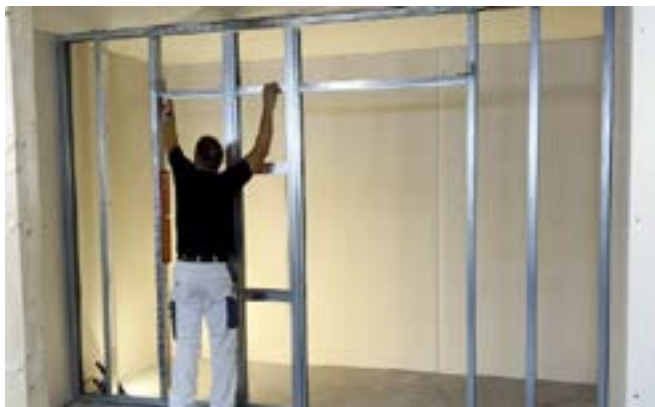
Фигура 22: Подравняване на Pocket Kit Easy Система за плъзгащи врати
