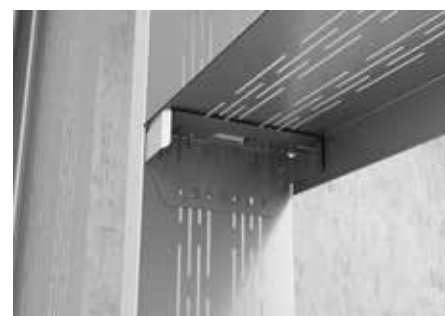
Nail Bracket til fastgørelse af skinne til stolpe over / under åbningen.
