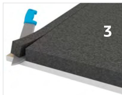
3. Ved start eller afslutning tilskæres isoleringsmaterialet, så det passer til stolpen. Brug en kniv eller fintandet sav.
