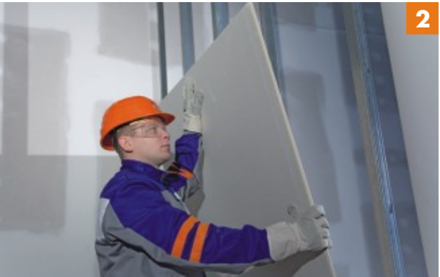
Montarea gips cartonului pe structura pregătită (ex. Knauf A13)
