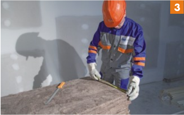
Măsurarea unei secțiuni predeterminate de izolație minerală, cu distanța standard de 600 mm
