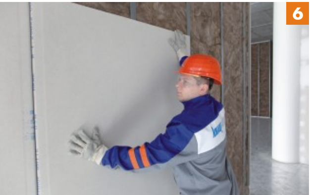
Montarea primului strat de gips carton pe structura pregătită (ex. Knauf A13)
