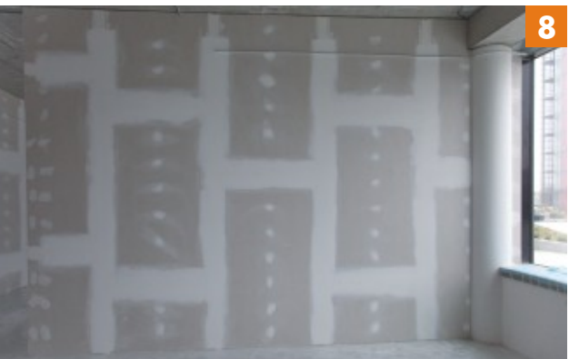
Etapă finală este aplicarea masei de șpaclu pe îmbinările plăcii și capetele șuruburilor de fixare
