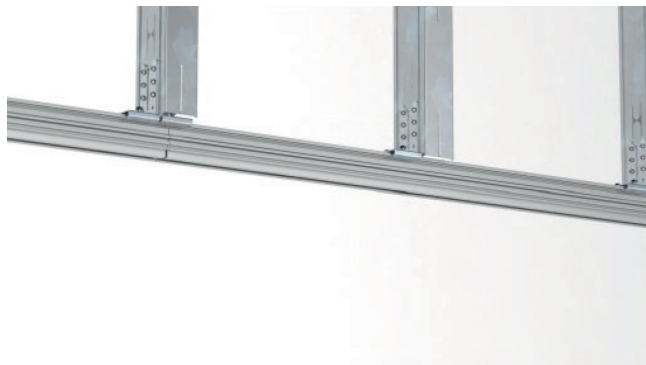
Bild 11: Fixieren und prüfen der Laufschienen
