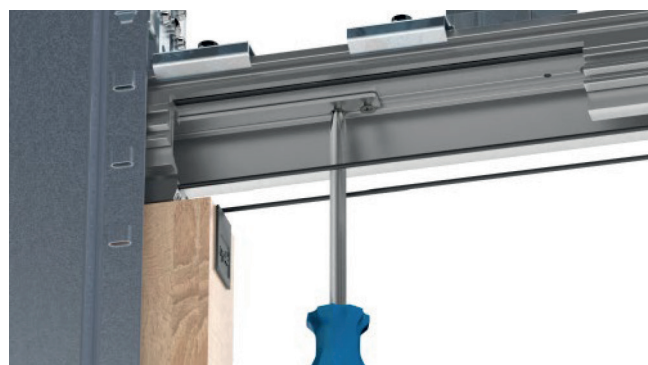
Bild 34: Ausrichten und Befestigen der Türen
