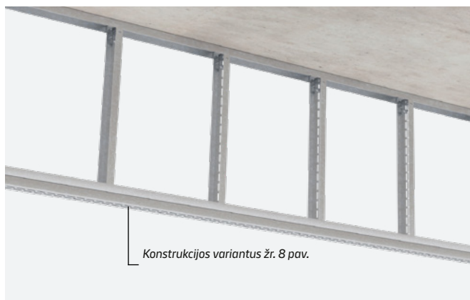
7 pav. UW profilio konstrukcijos apatiniame lubų atitvaro krašte montavimas
