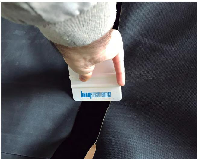
**4a.** Los solapes horizontales y opcionalmente los verticales (para obtener una completa hermeticidad si se deberán encintar los solapes verticales).
