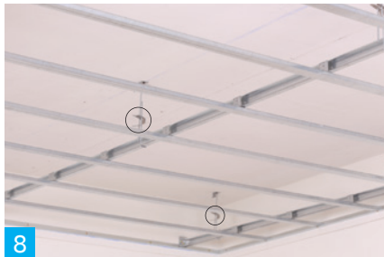
5 ประกอบชุดแขวนโดยจอลวด 4 มม. ที่ปลาย 50 มม. นำไปประกอบกับสปริงปรับระดับ และ ขอหิ้วโครงนำชุดแขวนปรับระดับติดตั้งกับฉากกึ่งพื้น
