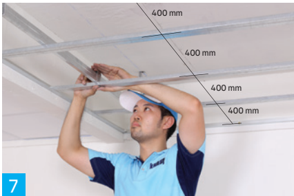
4 วัดระดับจากฉากกึ่งพื้นถึงระดับฉากริม เพื่อตัดลวด 4 มม. ให้ได้ตามระดับที่วัด
