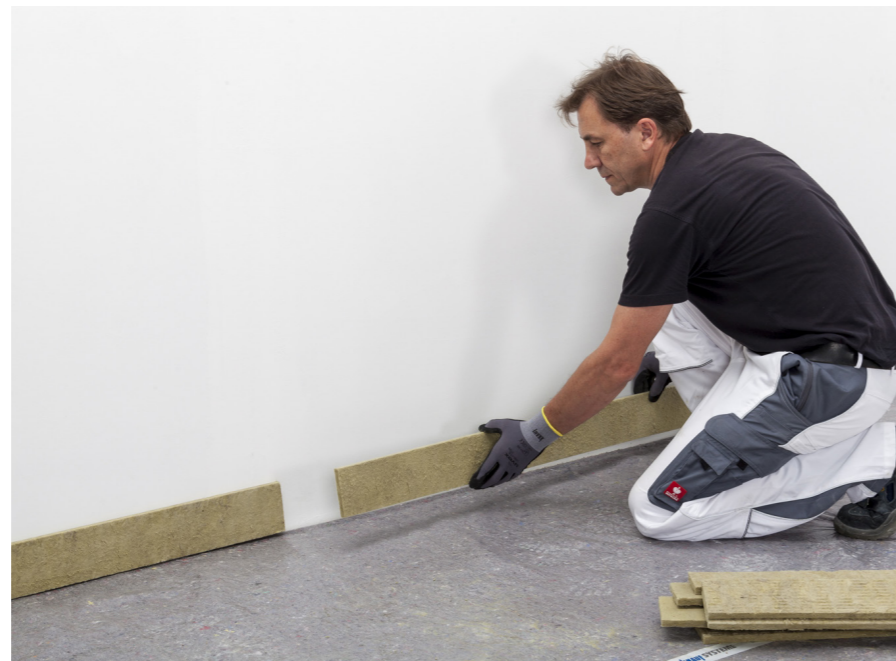
L'assemblage commence par la pose de bandes d'isolation périphériques.
