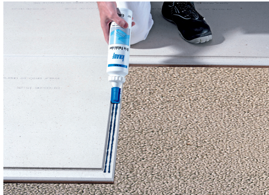
Collage de la feuilure de raccord avec deux cordons de colle Brio pour Brio.
