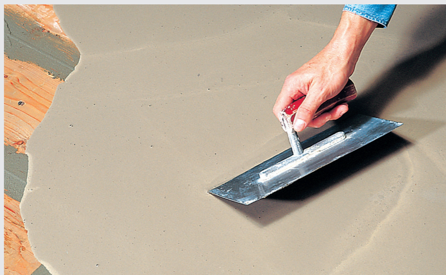
Égalisation d'un plancher en bois avec l'Égaline universelle Knauf.
