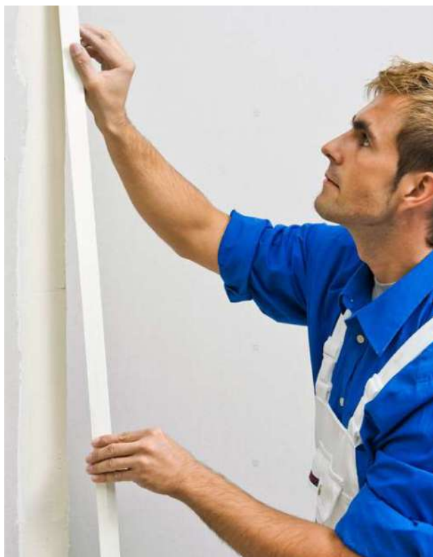
Pose de la cornière d'angle Alux...
