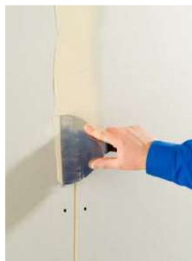
Application de l'enduit
