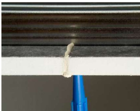
Vue latérale du remplissage des joints avec Knauf Uniflott
