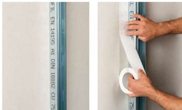
Monter le profilé sur le composant adjacent et coller Trenn-Fix PRO à côté du profilé
