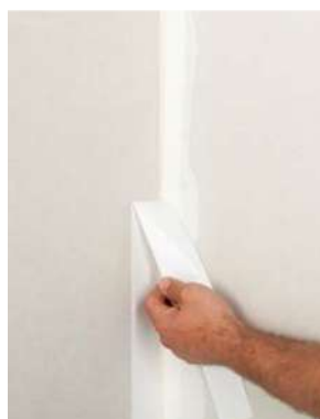
Après séchage et ponçage, couper Trenn-Fix dans l'angle et retirer la partie de bande qui dépasse.
