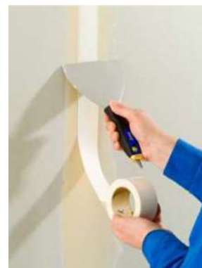
Pose de la bande couvre-joint
