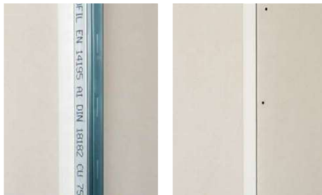
Faire adhérer Trenn-Fix PRO, lisser et monter les plaques de plâtre avec un espace de 5 mm environ.
