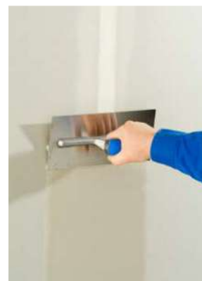
Pose de la bande couvre-joint
