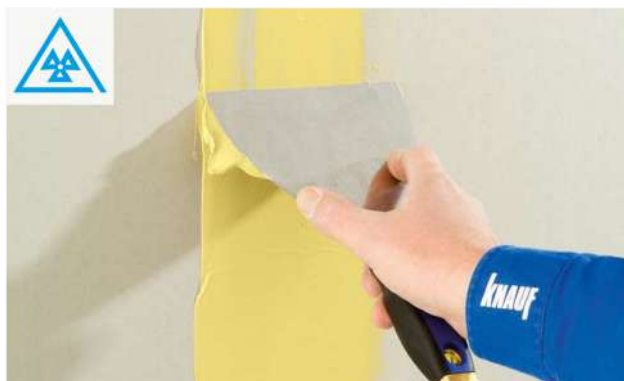
Enduit spécial joint Knauf Safeboard teinté jaune
