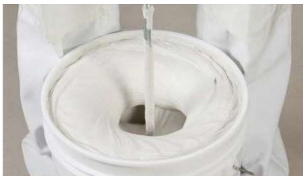
Malaxage de Knauf Universal Spritzspachtel au mélangeur.
