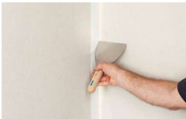
Mastiquer le joint.
