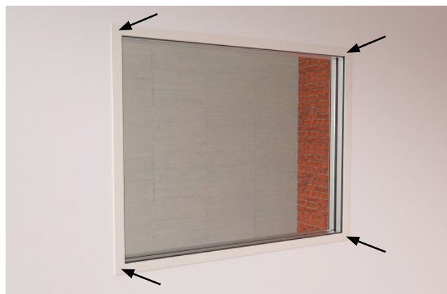
Bild 23: Abdeckrahmen eindrücken
