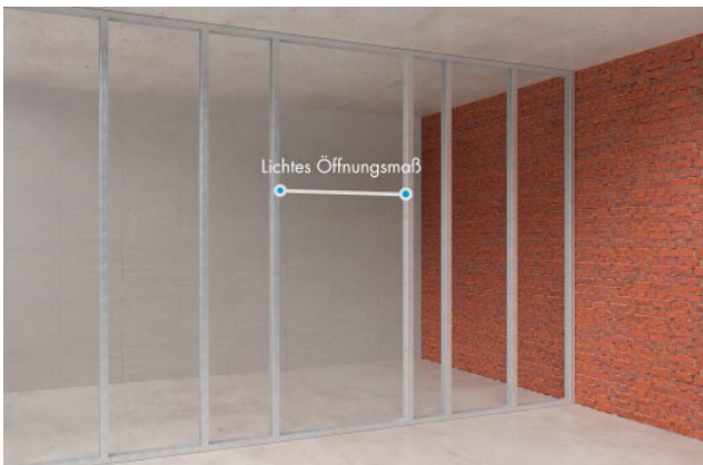
Bild 6: Zusätzliche CW-Ständerprofile einstellen
