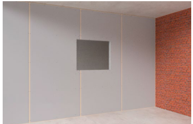
Bild 14: 1. Beplankungslage Vorderseite und Verspachtelung beider Seiten
