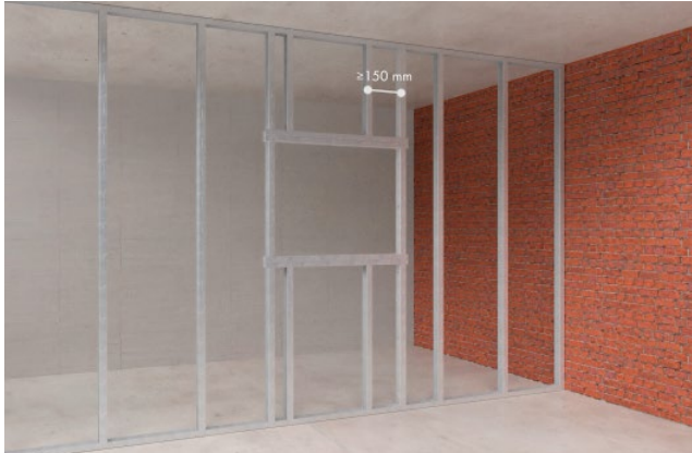
Bild 11: Fehlende CW-Profile einbauen
