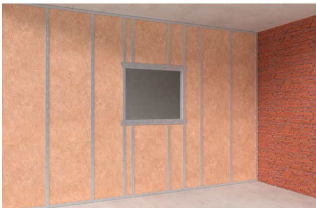
Bild 13: Dämmung einstellen
