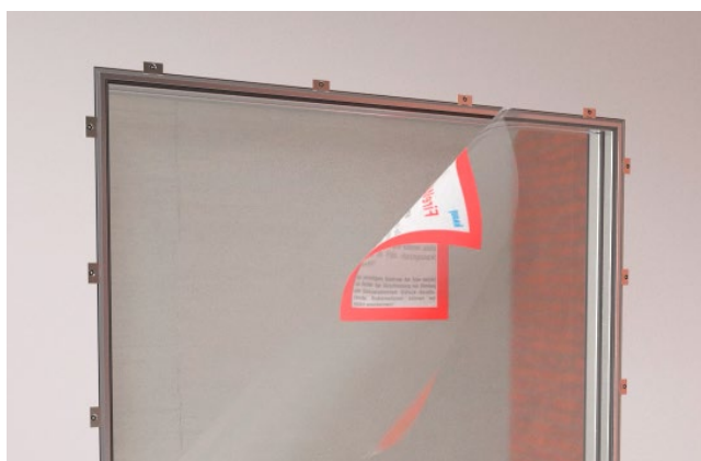
Bild 22: Schutzfolie entfernen
