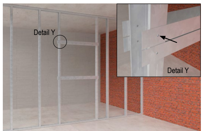
Bild 10: UW-Profile einbauen und vercrimpen
