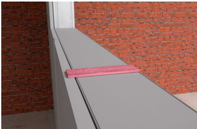
Bild 12: Bündigkeit prüfen
