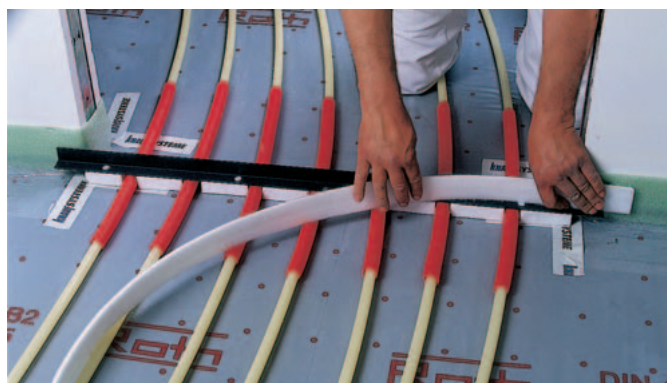
4. Selbstklebendes Bewegungsfugenband 10/70 einseitig an den Flansch des L-Profiles kleben.
