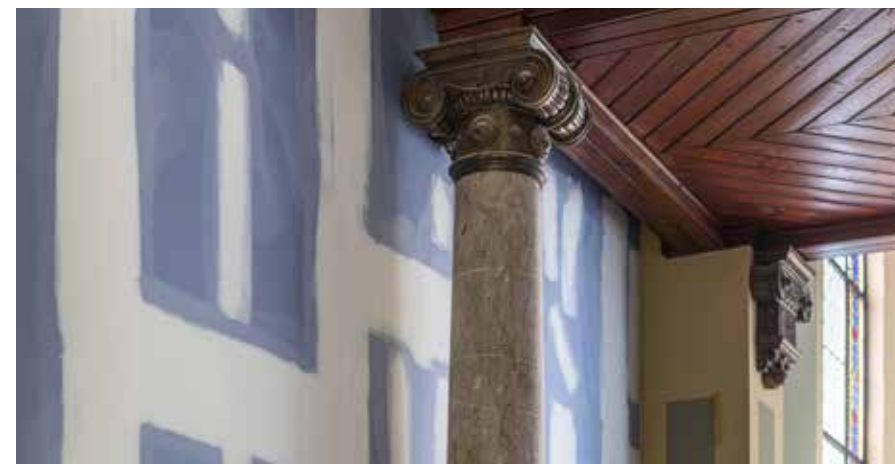
Oude en nieuwe bouwtechnieken komen samen bij het Heavens Hotel, in de voormalige Grote Kerk in Hoorn.
