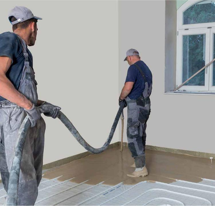
Beispiel eines geprüften Fußbodensystems der Feuerwiderstandsklasse F90
