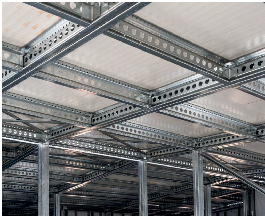
In alto dettaglio involucro edificio Knauf. In basso dettaglio impalcato strutturale
