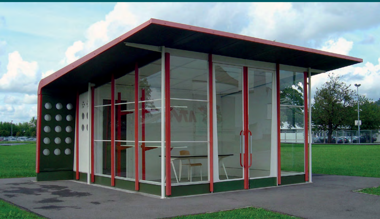
Stazione di servizio prefabbricata 1953, Jean Prouvé, Azienda Vitra, Weil am Rhein, Germania © en:User:Sandstein, a.k.a. User:TheBernFiles
