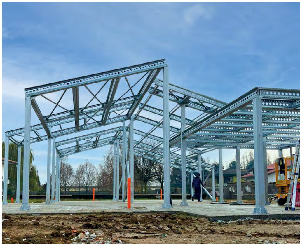
In alto dettaglio aggancio tra colonna e impalcato. In basso fasi di completamento del. montaggio della struttura portante
