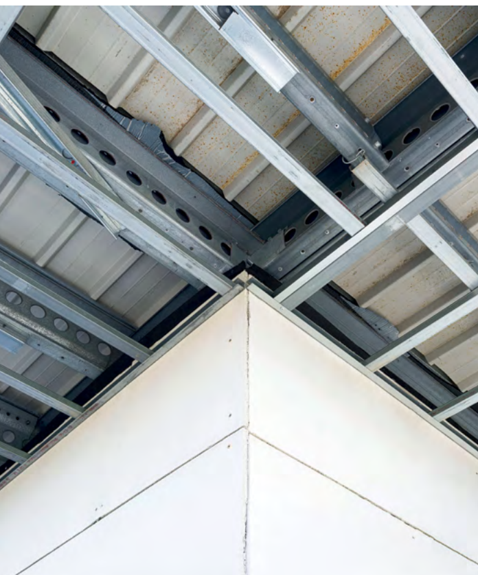
In alto foto panoramica della copertura piana realizzata con pannelli coibentati in lana minerale. A sinistra dettaglio attacco involucro su impalcato
