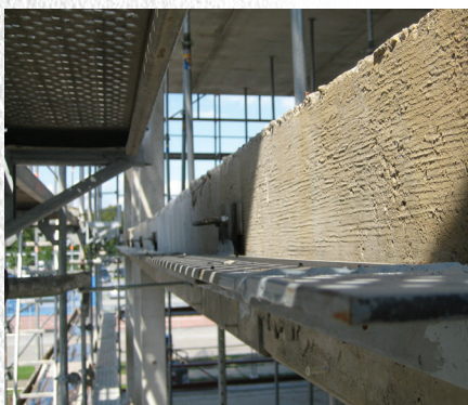
Kantoorgebouw | Voerde, Duitsland
