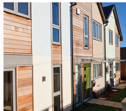
Woningbouw | Ringwood, Verenigd Koninkrijk
