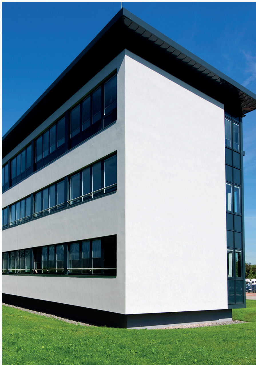
Kantoorgebouw | Voerde, Duitsland
