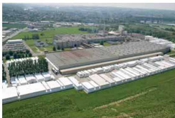
Site de production Knauf Insulation Visé
