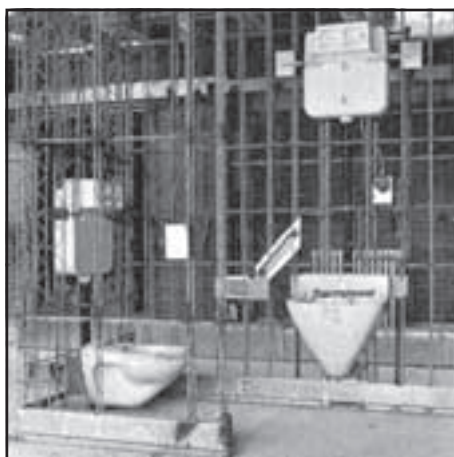
Vóór het bevestigen van de Stucanet®-panelen aan de Poutrafil® worden eerst alle leidingen voor sanitair, gas, elektriciteit,... ingebouwd en aan het skelet bevestigd.
