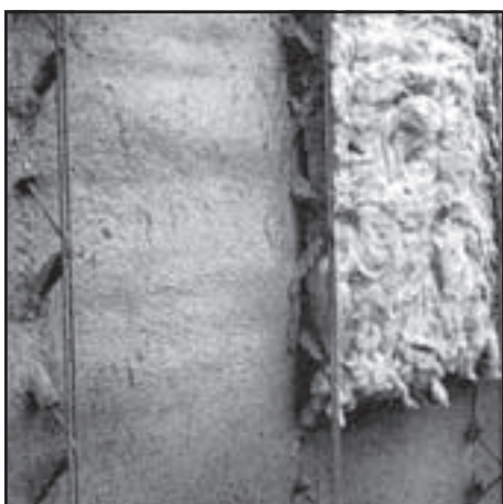
Stucanet® wordt aan beide zijden bespoten
