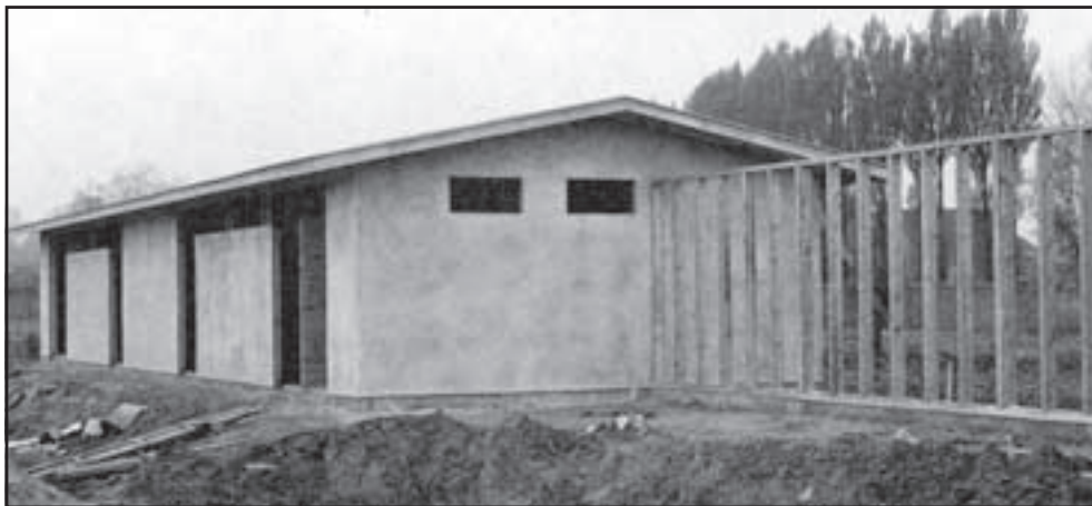
Ook een scheidingswand in Stucanet® is vlug geplaatst
