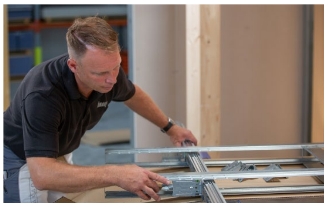
Bild 33: Einstellung Tragschiene
