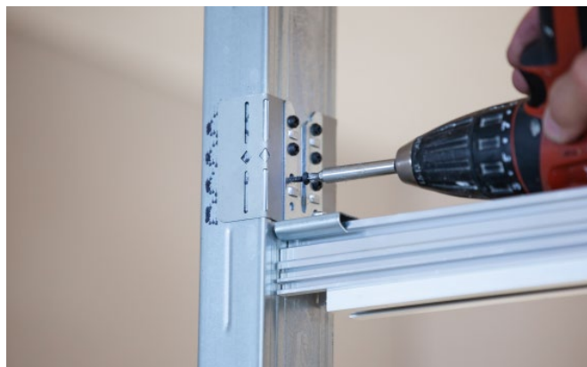
Bild 55: Sicherungslaschen entfernen
