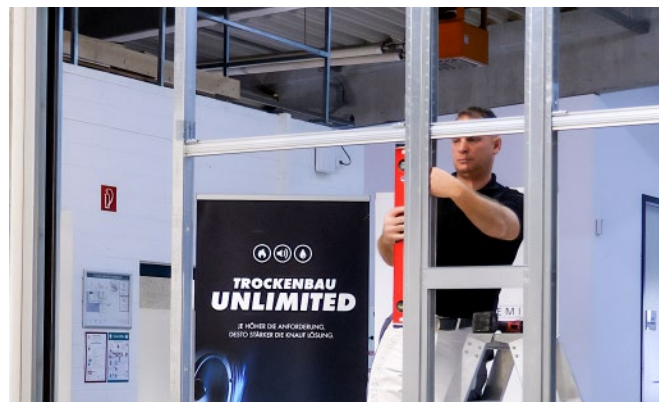
Bild 42: Taschenprofile ausrichten
