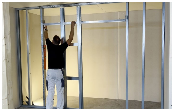
Bild 40: Sicherungslaschen umklappen
