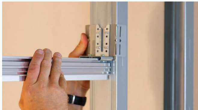
Bild 80: Taschenprofile über die Traversen verbinden
