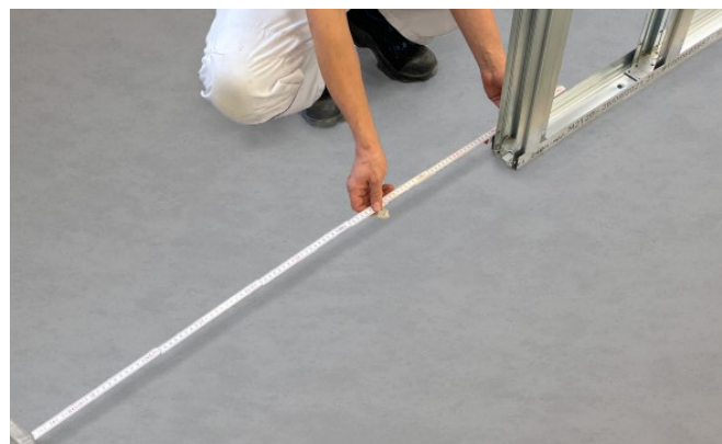
Bild 42: Taschenprofile ausrichten
