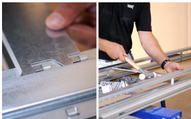
Bild 19: Distanzset montieren
