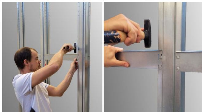
Bild 81: Befestigung Tragschiene
