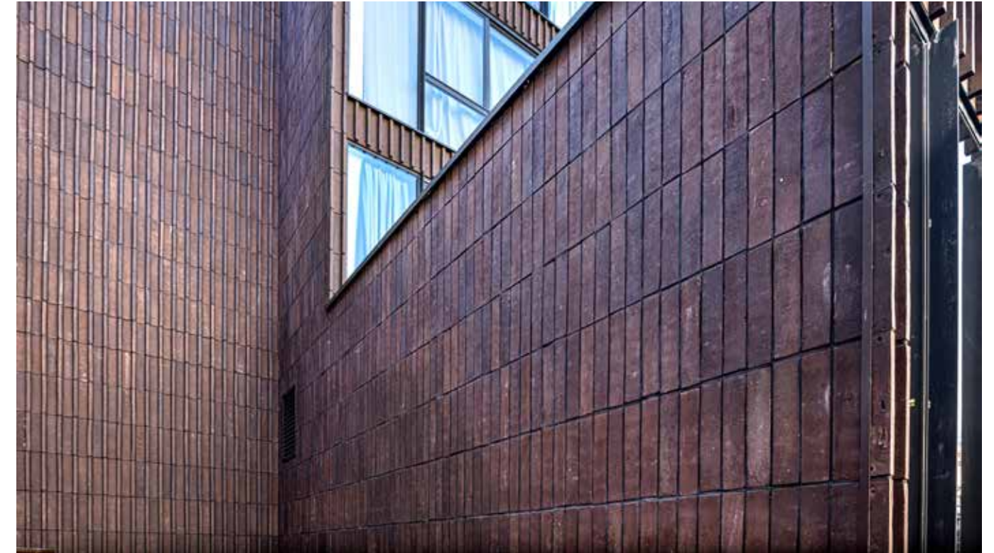
De stenen zijn in een steenstripachtige vorm verlijmd op het Knauf Aquapanel System.
