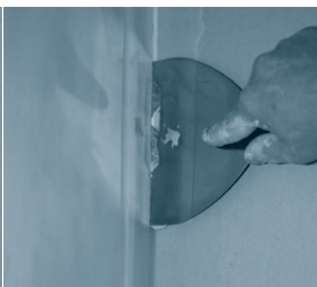
5. Stuccare dopo l'applicazione delle lastre.
