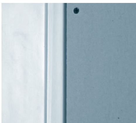
4. Applicare le lastre Knauf a distanza di 5 mm.
