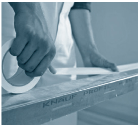
1. Applicazione del nastro autoadesivo Knauf Trennfix sul profilo a "C" o ad "U".
