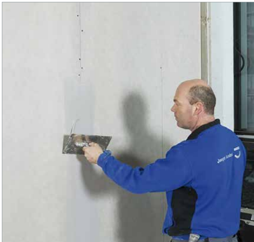
Afvoegen van Drystar Board met Drystar-Filler, in dit geval met wapening van Papierstrook.
