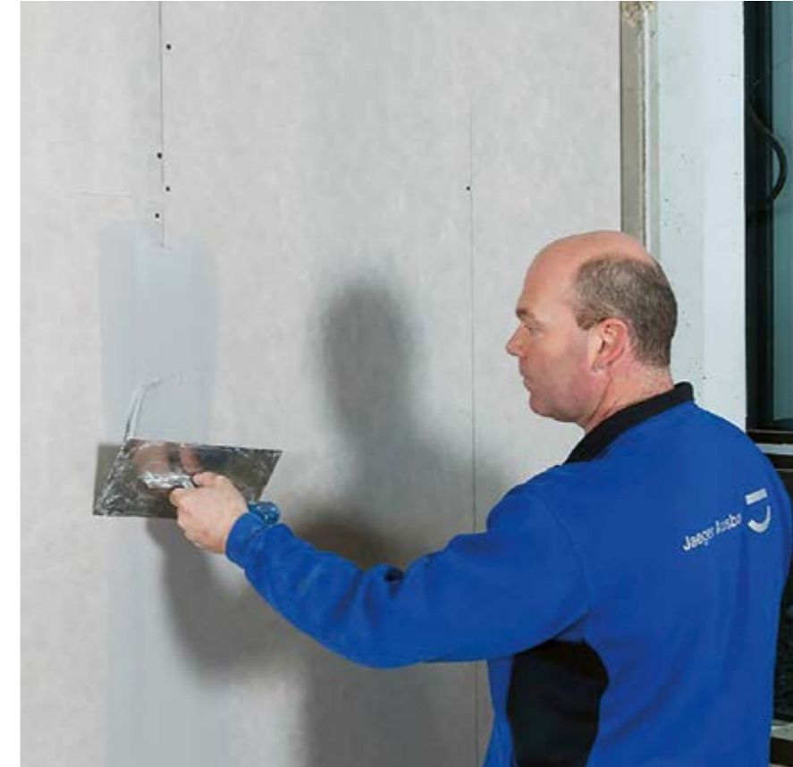
Afvoegen van Drystar Board met Drystar-Filler 60, in dit geval met Kurt wapeningsband.
