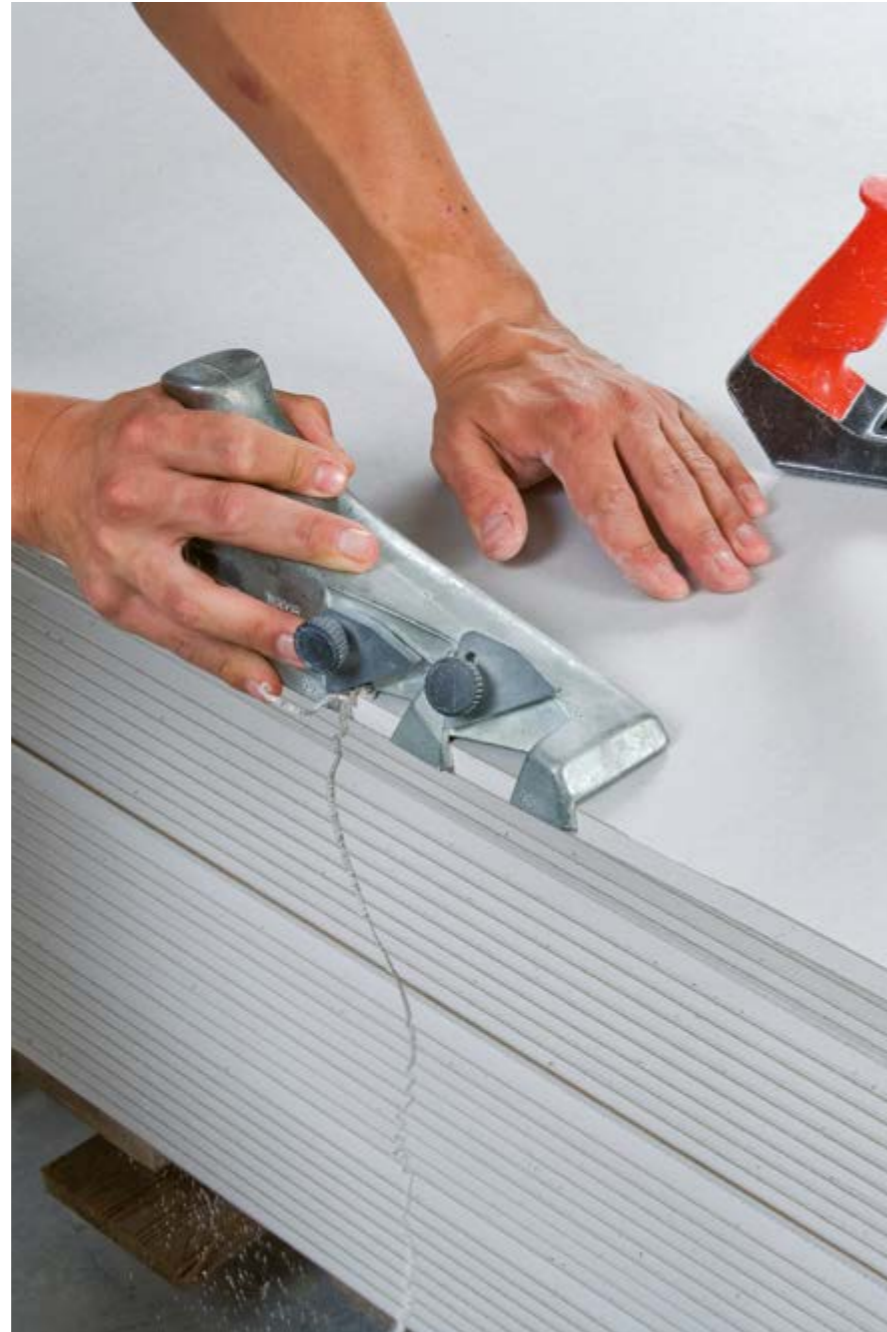
Kopse kant van Drystar Board facet schaven met de kantenschaaf.
