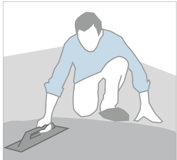
Forbrug: Knauf gulvspartlemasse N 410 ca. 1,6 kg/mm/m 2 - minimum lagtykkelse 2 mm.
