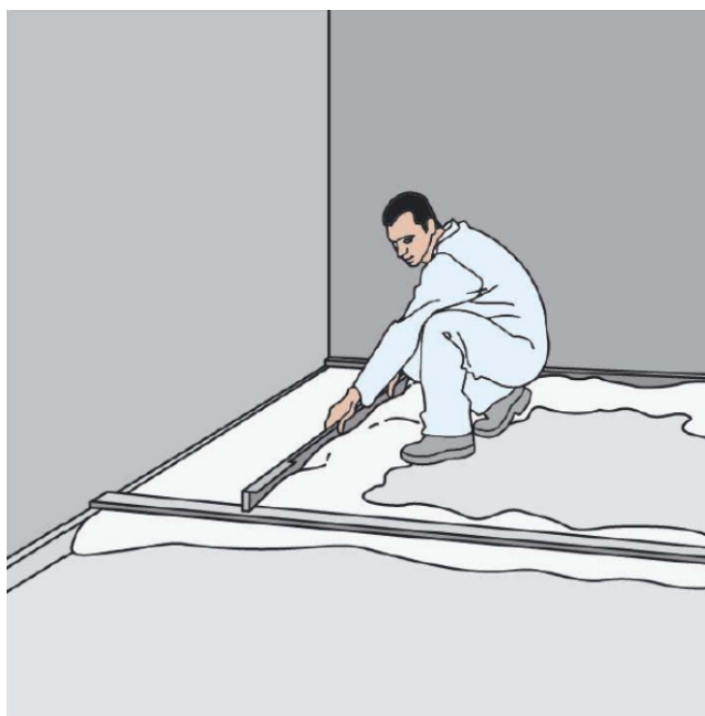
Figure 4 - mise en œuvre des granulats d'égalisation
