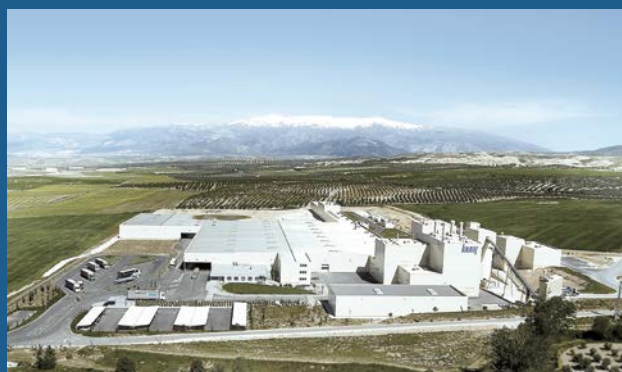
CENTRO DE PRODUÇÃO (placas de gesso laminado, perfis, pastas) EM ESCÚZAR (Granada), que iniciou a sua actividade em Março de 2008.
