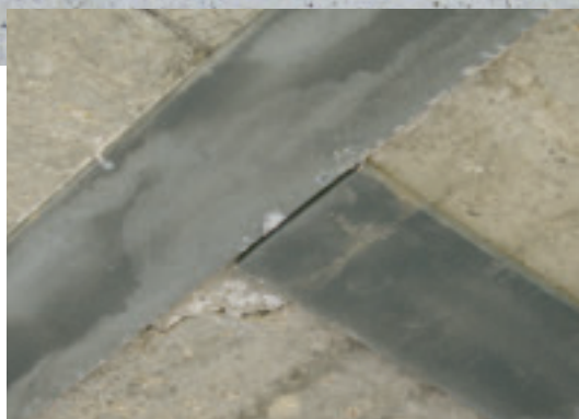
Ondergrond opgebouwd uit beton en metalen liggers.
