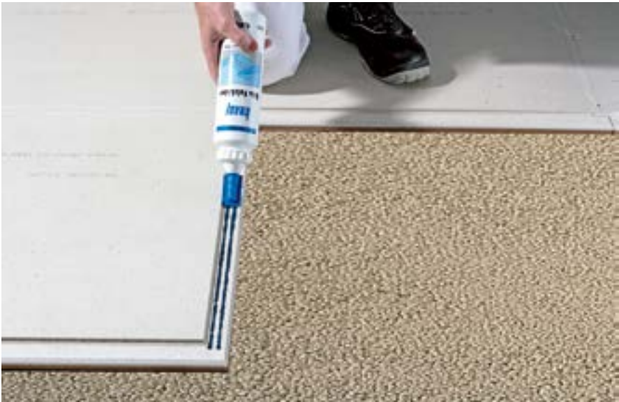
Verlijmen van de verbindinglip met twee rupsen Knauf Overlappingslijm.
