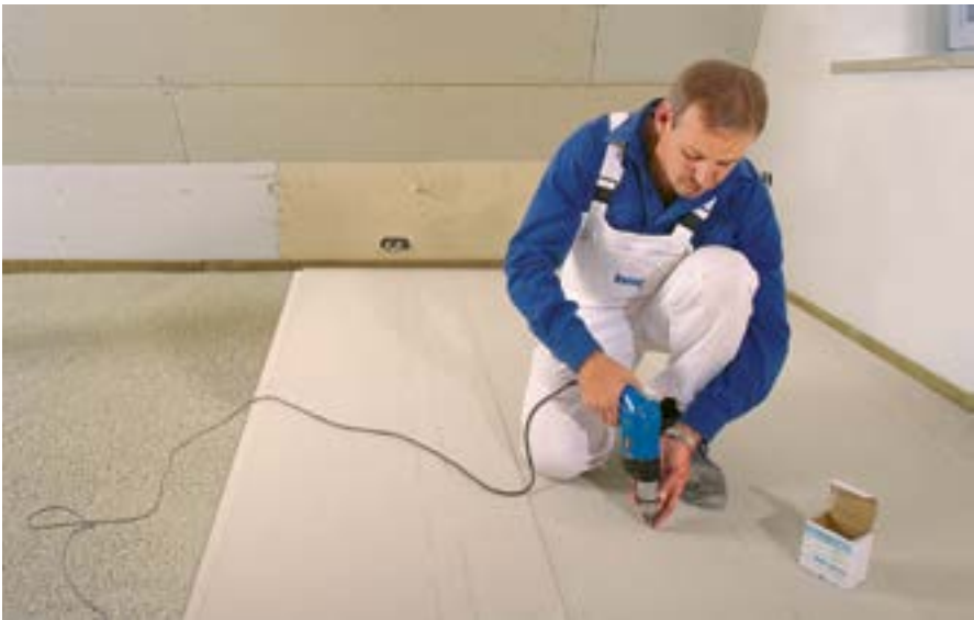
Het bovenliggende Knauf Brio element tijdens het lijmen en schroeven (of nieten) aandrukken met het eigen lichaams-gewicht.
