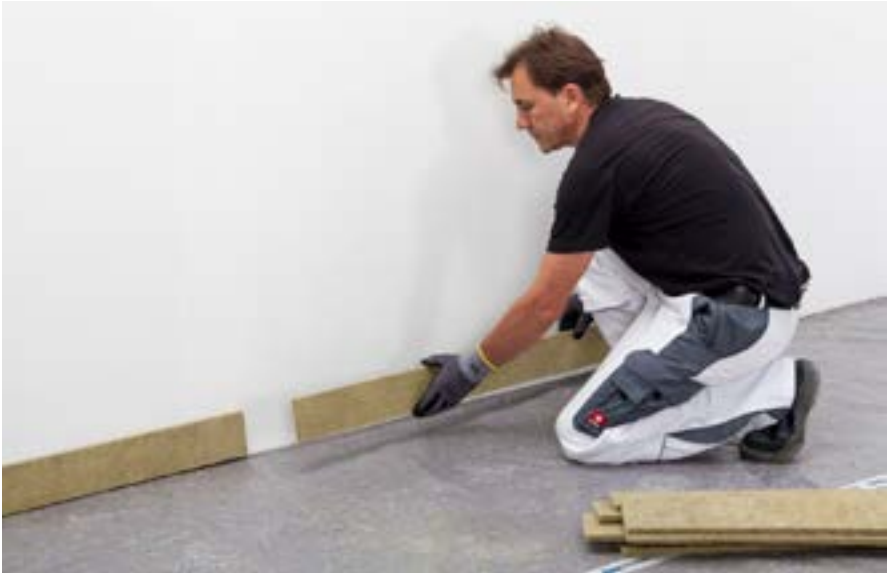
De montage begint met het aanbrengen van randisolatiestroken.
