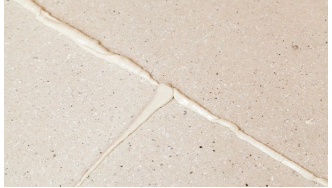
Bild 13: Press fit GIFAfloor PRESTO elements.
