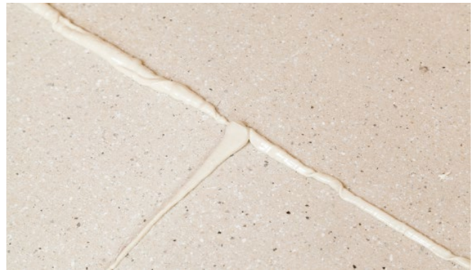
Bild 20: Press fit GIFAfloor PRESTO elements.
