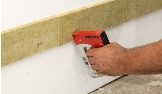
Bild 6: Secure GIFAfloor edge insulation strips with staples or Knauf Uniflott.
