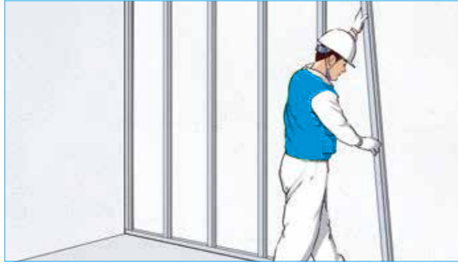
1 상하부 러너 및 스테드 시공
