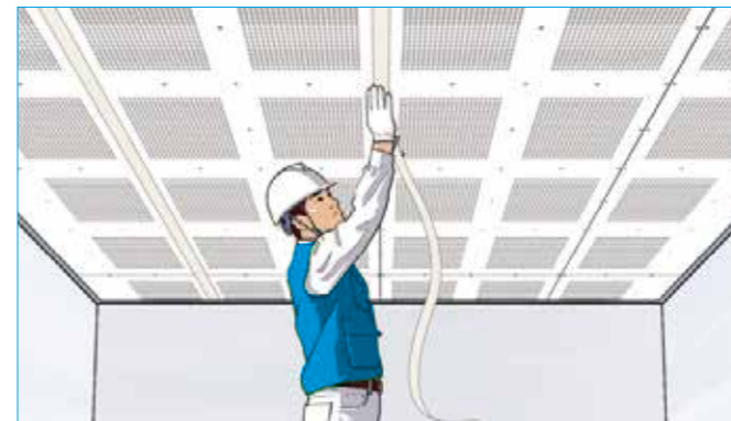
5 이음매 부위에 조인트 컴파운드를 도포합니다. *크나우프의 마스터퍼티를 사용하시면 더욱 깔끔한 일매이음마감이 가능합니다.
