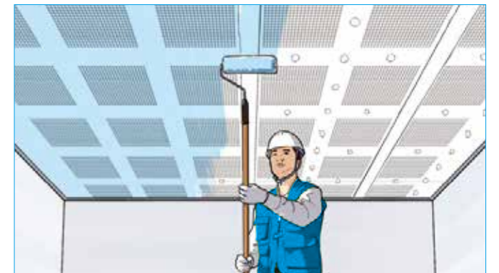
6 이음매 부위 컴파운드 도포 건조 후 페인트를 도포하여 시공을 마무리합니다.
