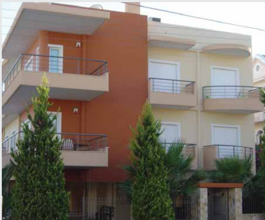
Ανακαινισμένη κατοικία με το αντιρηγματικό σύστημα Knauf, στο Π. Φάληρο
