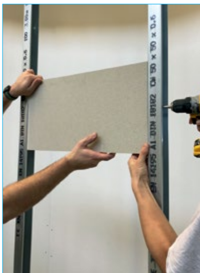
2 Kinnitage traavers külgedelt CW-profiili külge
