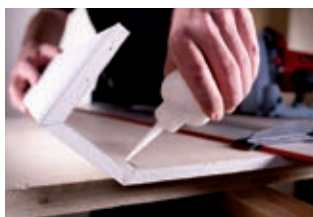
Piegatura e incollaggio Diamant SX Knauf (foto: © Mafell AG)
