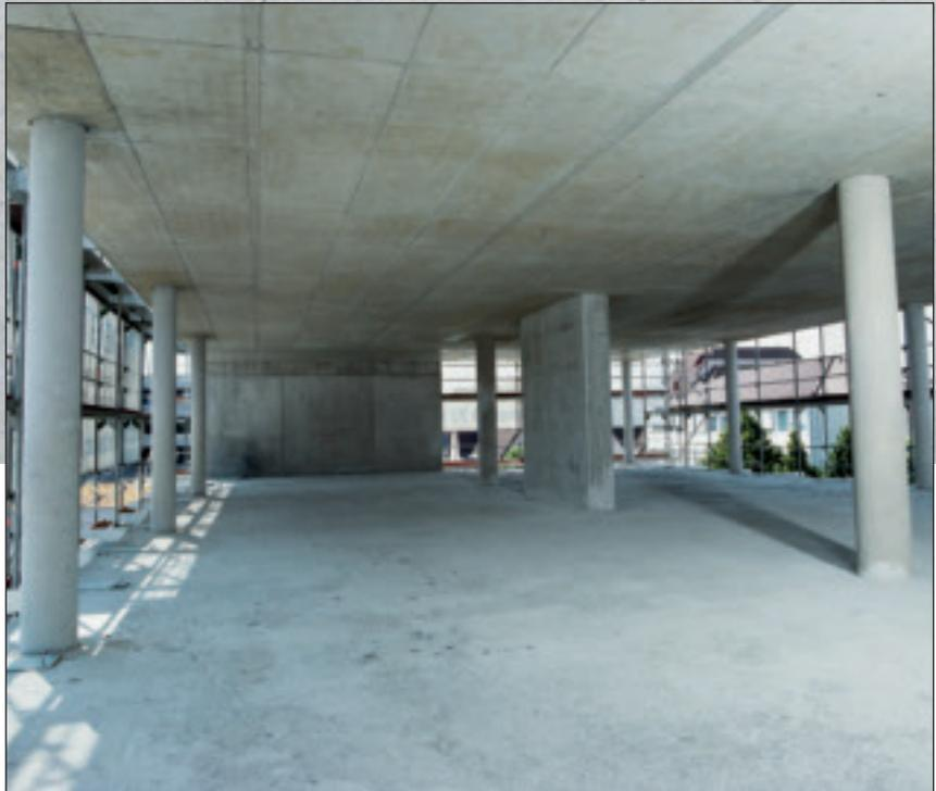
Grâce aux procédés actuels, le plâtre est devenu le matériau le plus utilisé pour le parachèvement des surfaces intérieures, que celles-ci soient constituées de briques en terre cuite, de blocs en béton, en béton cellulaire ou silicocalcaires ou encore d'éléments en béton préfabriqués ou coulés sur site. Néanmoins, sur ces derniers, quelques cas de décollement de l'enduit ont été recensés ces dernières années.
