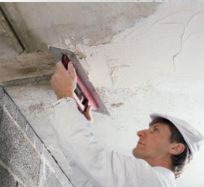
pour des ouvrages coulés sur site (voile ou dalle) et la durée de séchage (trois mois) ne démarre qu'après leur décoffrage. Une température du support ainsi qu'une température de l'air ambiant constantes d'au moins 5°C sont exigées avant, pendant et après les travaux de plâtrage. Ni le pont d'accrochage ni l'enduit ne peuvent être appliqués sur un support gelé.
