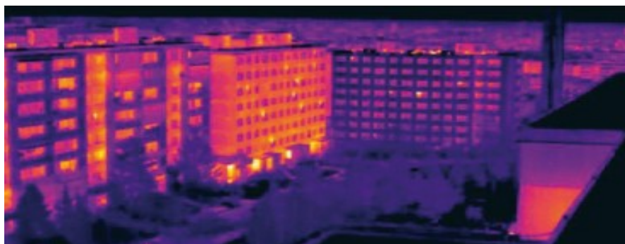
Poza în infraroșu a unui ansamblu rezidențial cu blocuri, ce arată pierderile de căldură. Zonele roșii și galbene la culoare suferă pierderi de căldură mai accentuate, decât zonele albastre.
