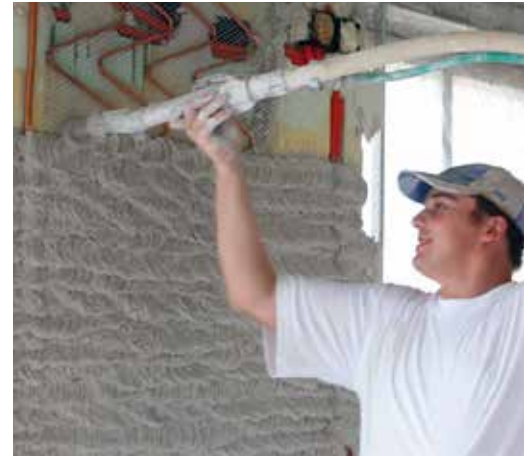
Ευχάριστα ζεστές επιφάνειες: Τα ωφέλη των τοίχων θέρμανσης ενισχύονται από την υψηλή θερμική αγωγιμότητα του γυψοσβά Knauf MP75 Diamant.
