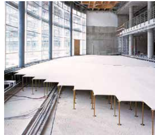
Υπερυψωμένο δάπεδο GIFAfloor FHB plus με στηρίγματα και διπλή στρώση πλακών και τοποθέτηση εγκαταστάσεων στο διάκενο
