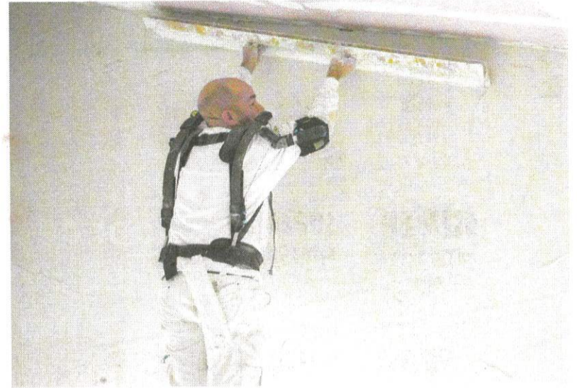
Het afreien van plafonds bleek het werk waar de stukadoors het skelet het vaakst bij inzetten
