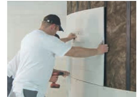
3 An gerundete Unterkonstruktion schrauben
