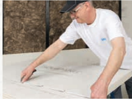
1 Platte bauseits tief einritzen
