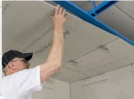
1 Platten mit 4 mm Fugenabstand montieren
