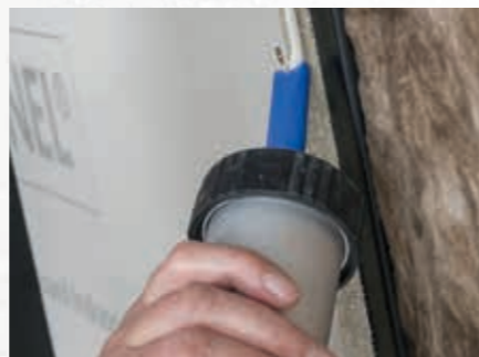
2 Kleberraupe über die ganze Kante auftragen
