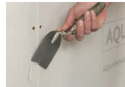
4 Nach einer Trocknungszeit von ca. 12 – 16 Stunden* (am Folgetag) wird der überstehende Kleber abgestoßen.
