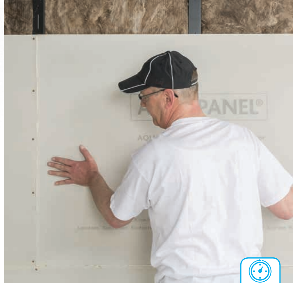
3 Die Platten senkrecht einstellen und stumpf stoßen. Der Kleber quillt gleichmäßig aus der Fuge.
