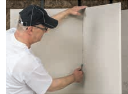
3 Gewebe auf der Rückseite durchtrennen
