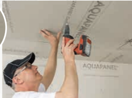
3 Ohne Vorbohren verschrauben
