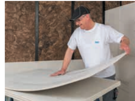
1 Plattenstruktur mechanisch lockern, im Liegen ...
